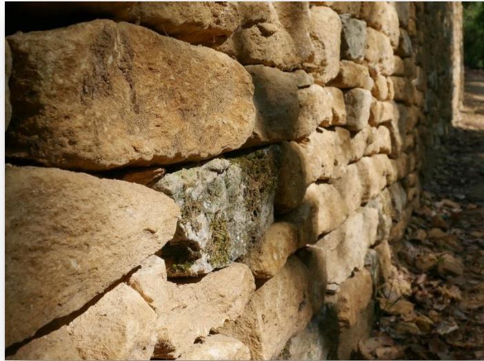
Figure 16 : Mur récemment restauré contenant des pierres de l'ancien ouvrage
