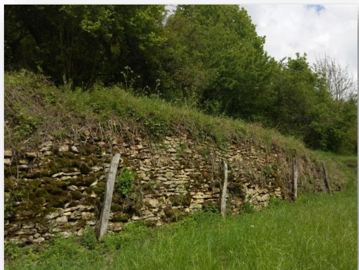
Figure 7 : Mur situé à Rembercourt et associé à un stade 1
