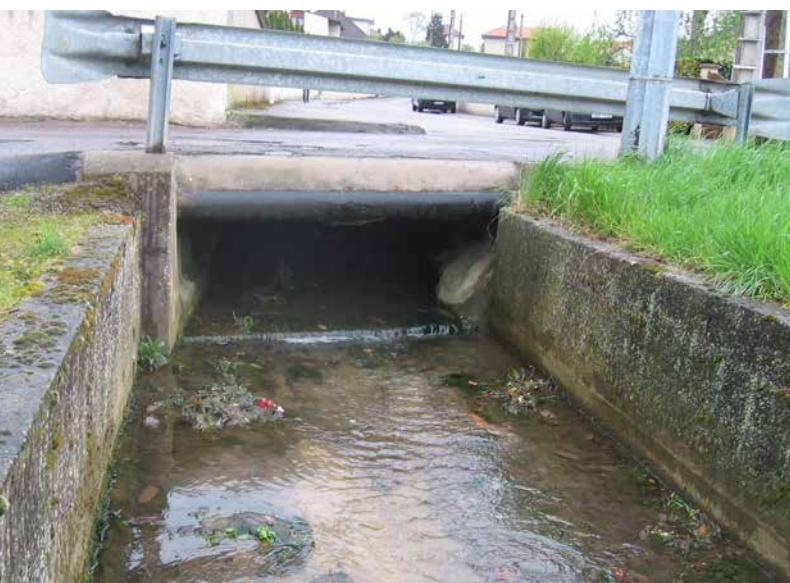
■ Portion souterraine d'un cours d'eau
