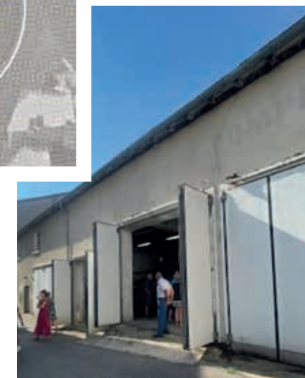
Ancienne caserne de pompiers
